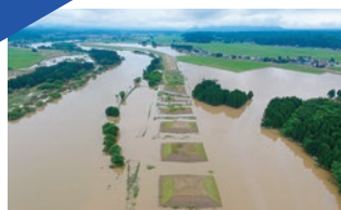
河川災害の現況調査
